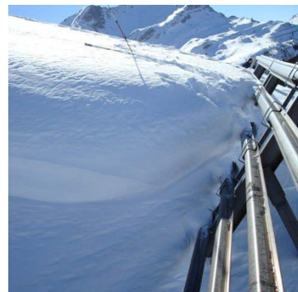
Eingeschneite Schneebrücke vom Typ SB, DK 4.0 m im Anbruchgebiet Vallatsch II Pignia GR
